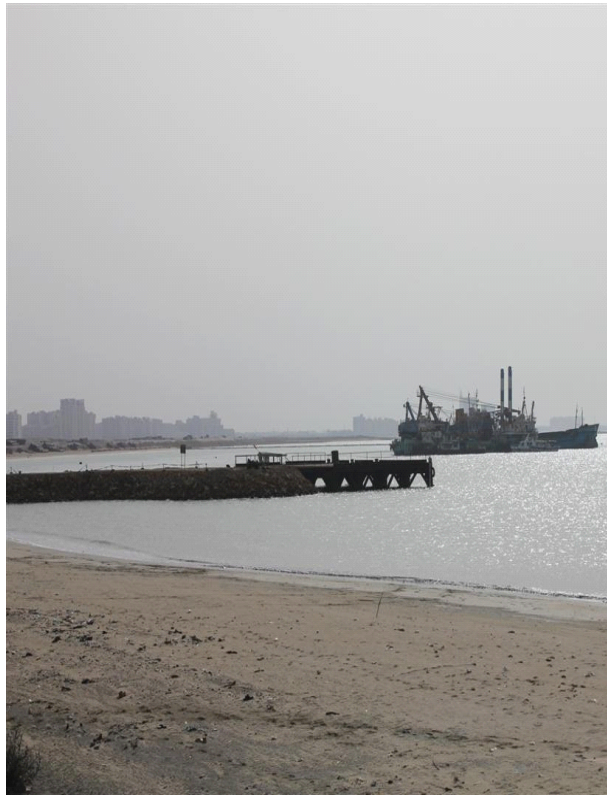
(图为临时码头完工)
