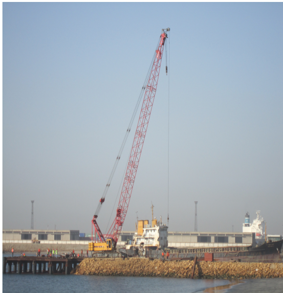
(图为临时码头面层施工)
