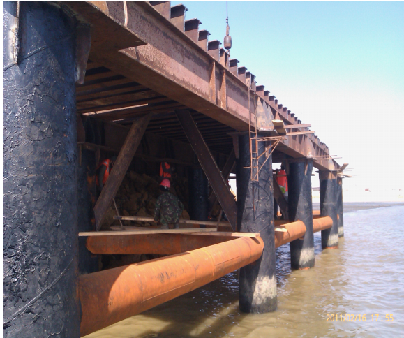
(图为临时码头斜撑和下横联施工)
