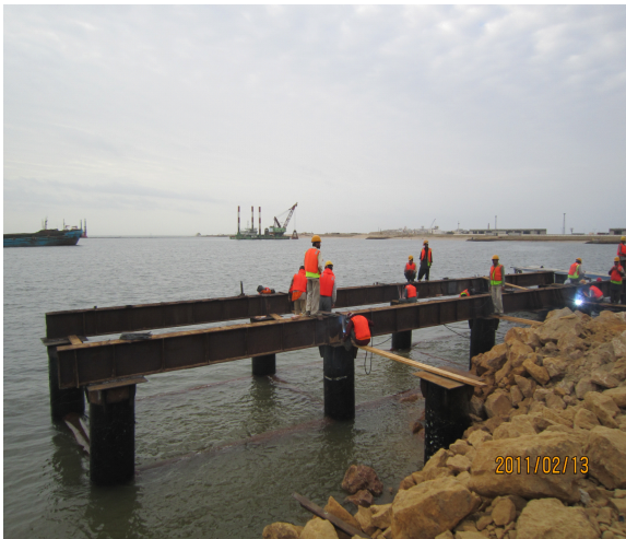
(图为临时码头主横梁施工)
