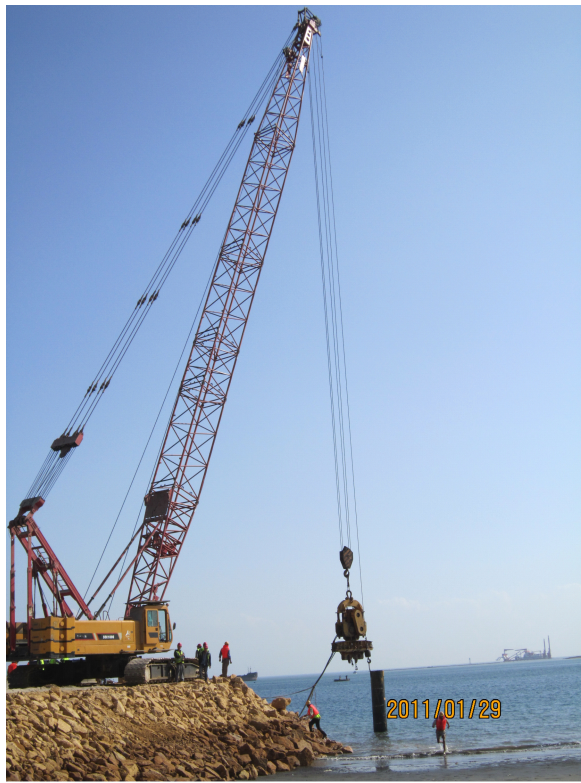
(图为2011年1月29日临时码头打桩)
