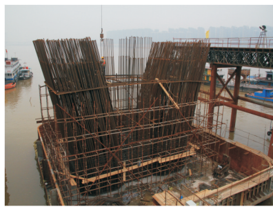
主墩PM19墩身钢筋绑扎成型
