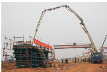
陆上引桥首个墩身浇筑施工现场
