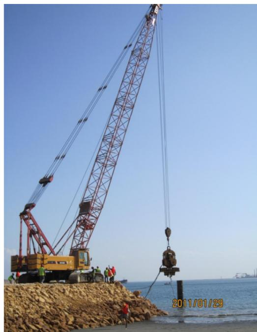
2011年1月29日上午10点整，巴基斯坦深水港项目临时码头施工现场一片沸腾，加长平板车通过预制场已顺利将直径为0.8米，长度约15米的3根钢管桩运至现场，随着100T履带吊的缓缓启动，吊桩、立桩、夹桩，再经过测量的精确定位后，DZ120型振动锤正式开始了临时码头钢管桩施工，标志着深水港项目的水上施工正式启动。
