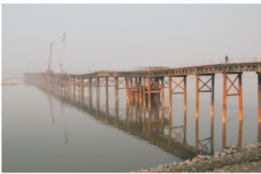
（徐尧、黄忠满）钢栈桥河东岸上推进与河中92排顺利对接合龙
