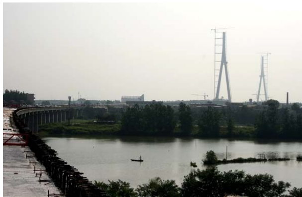
主桥与引桥贯通后，鄂东大桥的雄姿
