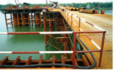
龙虎山大桥施工现场全景
