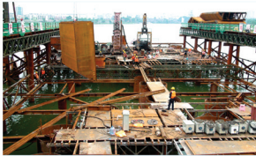
9号主墩桩基施工顺利完成，钢围堰拼装开始施工。
