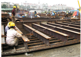
两桥钢围堰拼装施工现场
