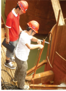
陈心恒在9号主墩上认真测量钢围堰内河床得标高。
