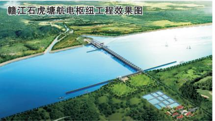
赣江石虎塘航电枢纽工程是赣江主要梯级航电枢纽之一，是实现赣江中游全河段渠化建设的关键工程和实现赣洲至南昌三级航道的重要组成部分。该工程坝址位于县城公路桥下游26km的万合镇石虎塘自然村附近，是以航运为主、结合发电，兼顾其他效益的水资源综合利用工程。总库容7.43亿立方米，电站装机容量12万千瓦，年平均发电量5.27亿度，通航设施建设标准为内河III级。工程总投资23.7亿元。
